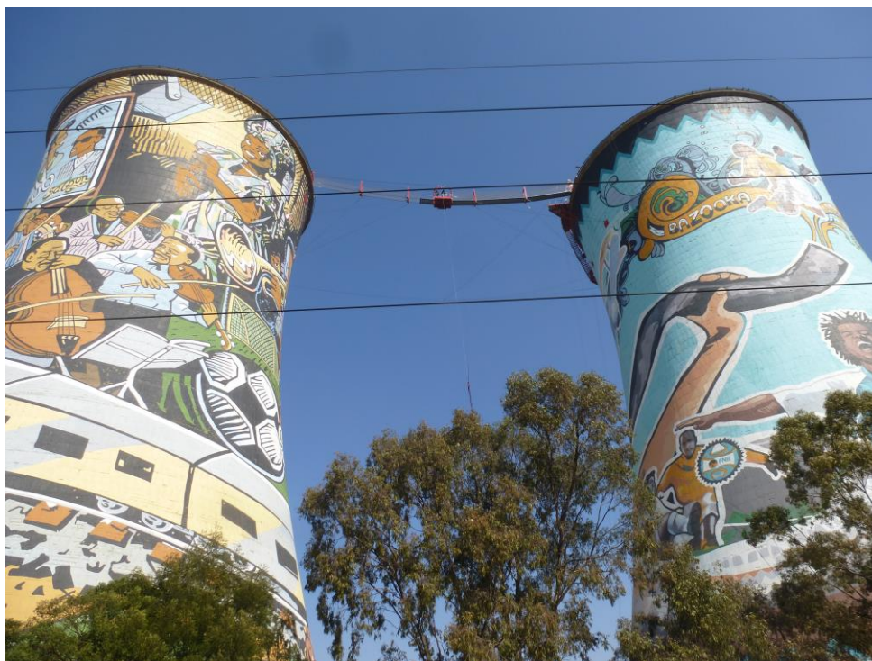
Foto: Symbol Soweta: pomalovane chladiace veze byvalej elektrarne
